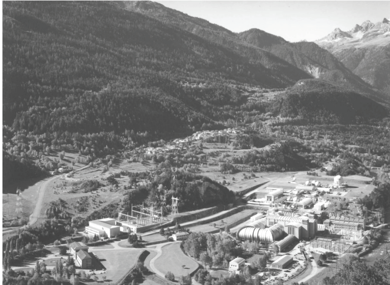
Vue générale du Centre Paul Dumaon à Modane –Avrieux
